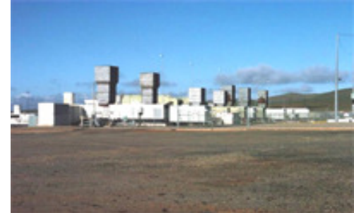
Hallett power station, SA
